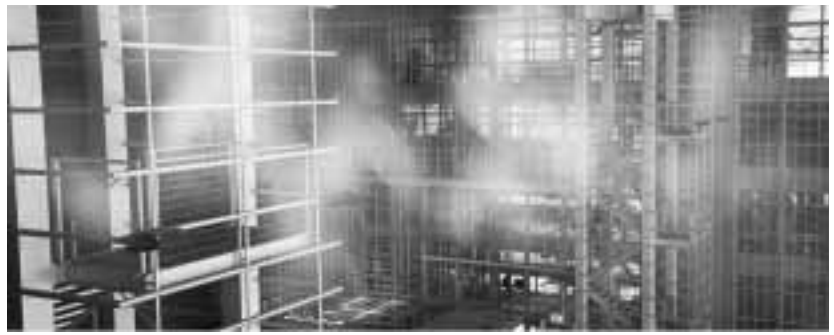
Keine Panik, das KKL ist nicht für einen Umbau eingerüstet... Die Lichtreflexe in den filigranen Elementen der Fassade wirken geradezu impressionistisch.
